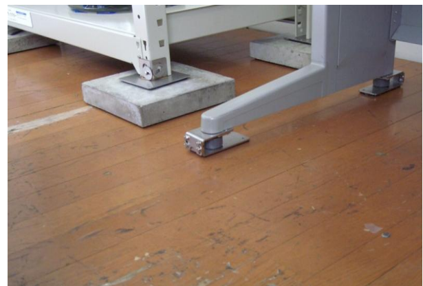
①棚 ラックスター(コンクリート上の固定) ②パソコン台 アジャスター
